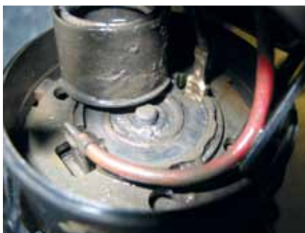
Aggressives Abgaskondensat im Antriebsmotor einer Sekundär-luftpumpe
