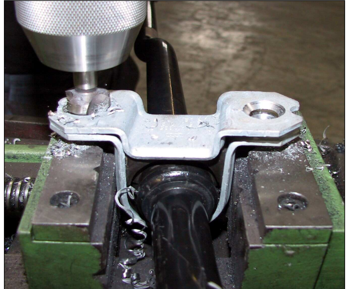
Abb. 2: Aufbohren der Nietverbindung Fig. 2: Drilling of the rivet connection
